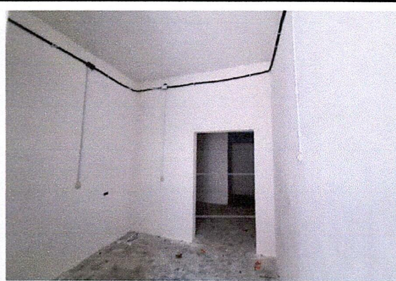
Foto 4: Reparación del Sistema Eléctrico
