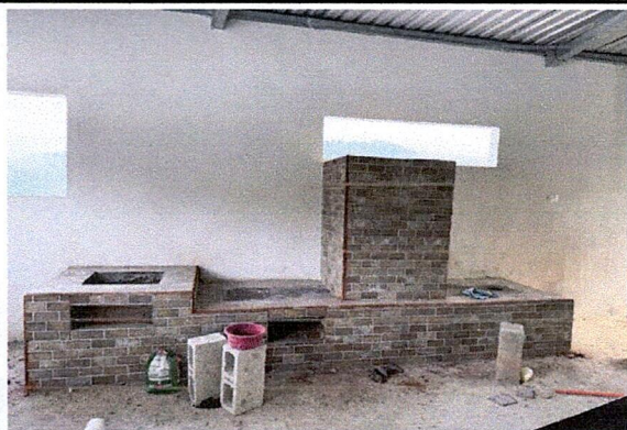
Foto 1: Reparación o sustitución de área de cocina.
