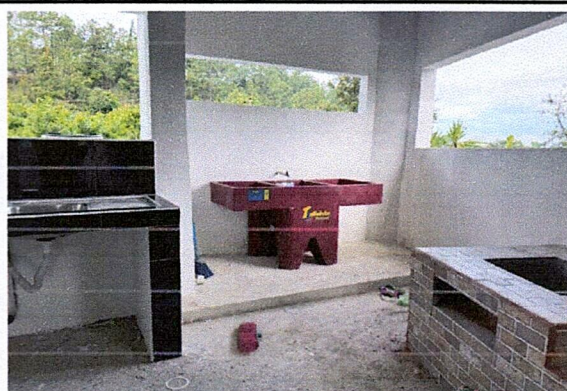
Foto 2: Reparación o sustitución de área de cocina.
