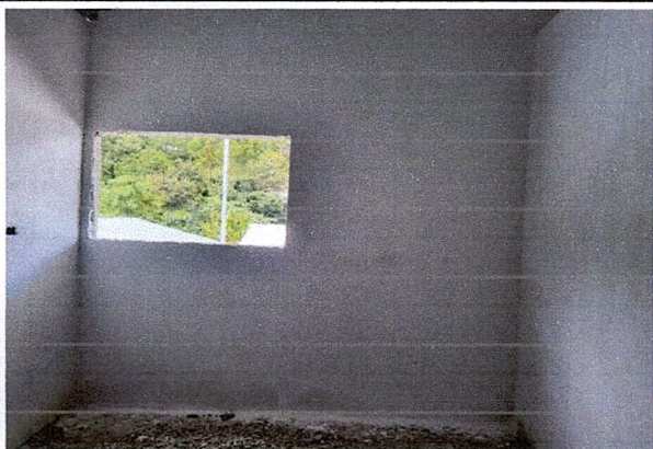
Foto 3: Reparación de Repello y sernido de paredes
